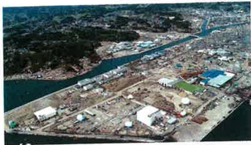
震災後、石油タンクが23基ありましたが、津波で20基流出しました
