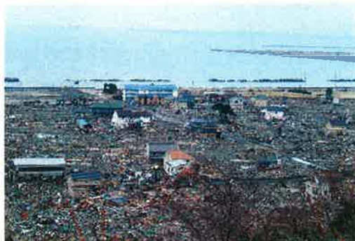
津波被害を受けた石巻市（南浜地区）
