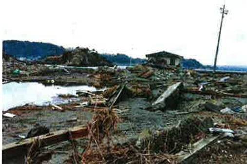
野々島の被災状況
