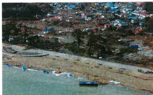
桂島の被災状況空撮
