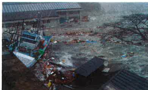
津波直後 役場屋上から庁舎へ船が激突
