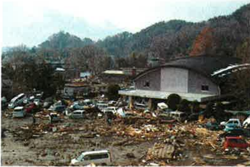
野蒜小学校体育館
