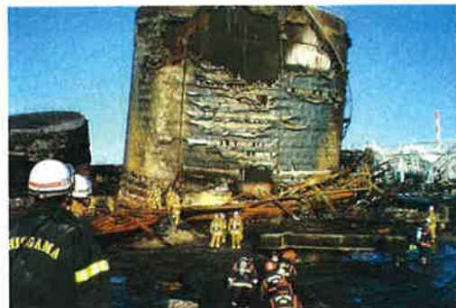
JX日鉱日石エネルギー(株)仙台製油所火災現場
